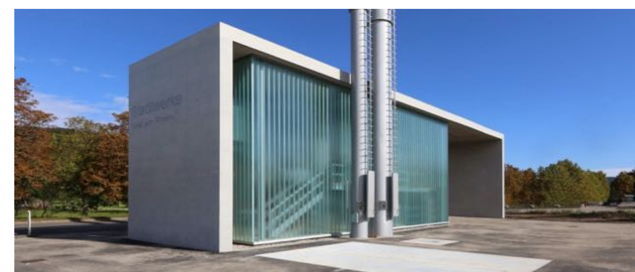
Biomasse-Heizzentrale Weil am Rhein
